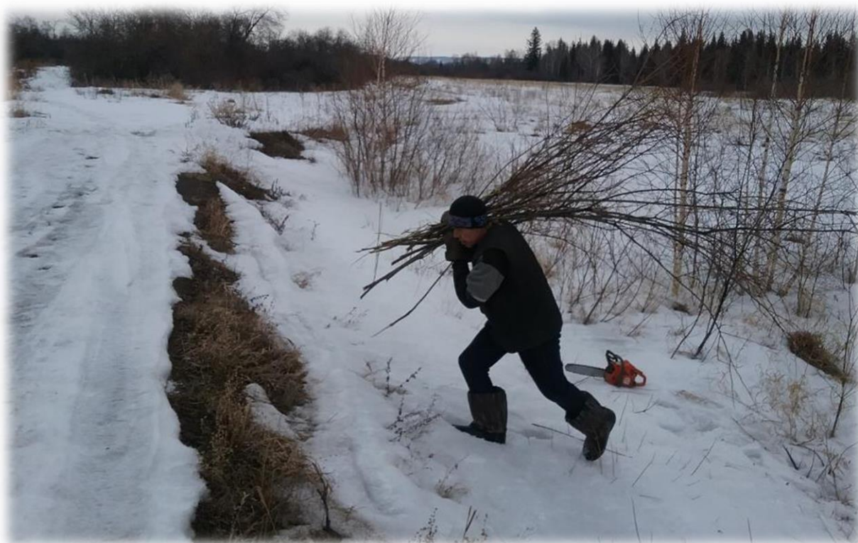
Фото 3. Вырезка и уборка кустарника на откосах дамбы на р. Вихоревка с. Кузнецовка.
