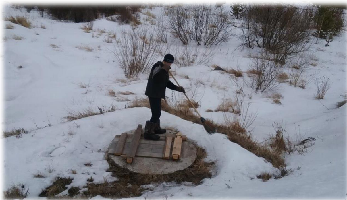
Фото 3. Очистка водопропускных колодцев дамбы от снега и наледи на р. Вихоревка с. Кузнецовка.
