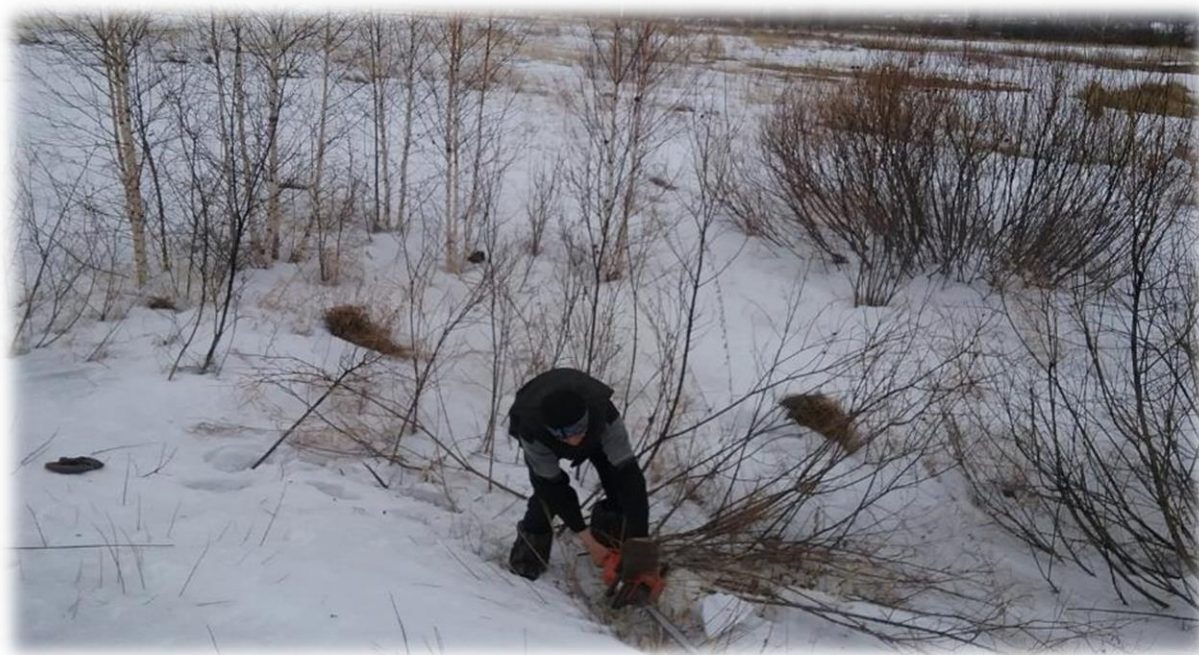
Фото 2. Вырезка кустарника на откосах дамбы на р. Вихоревка с. Кузнецовка.
