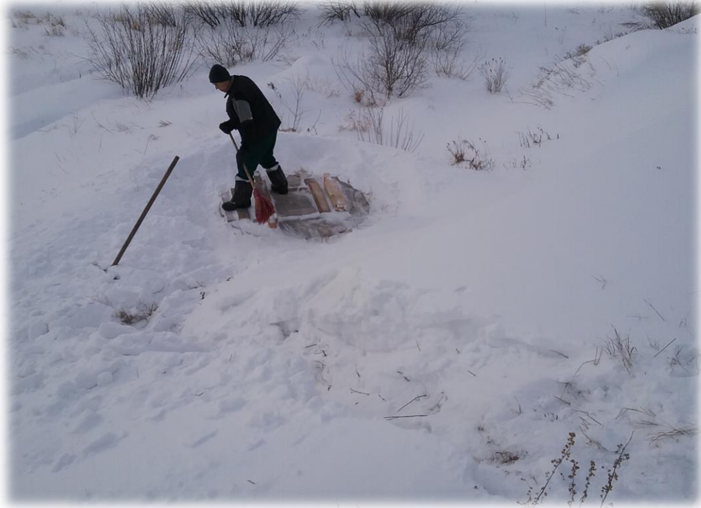
Очистка водопропускных колодцев дамбы от снега на р. Вихоревка с. Кузнецовка.
