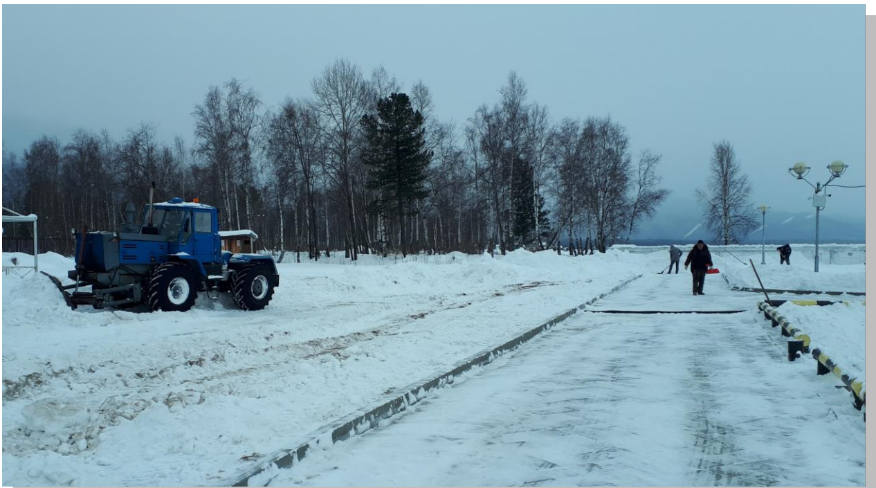
Уборка снега на ГТС.
