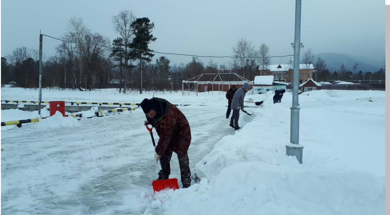
Уборка снега на ГТС.
