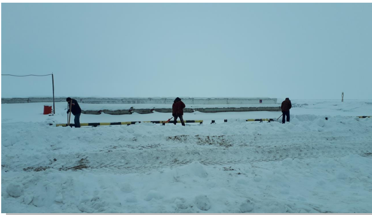
Уборка снега на ГТС.
