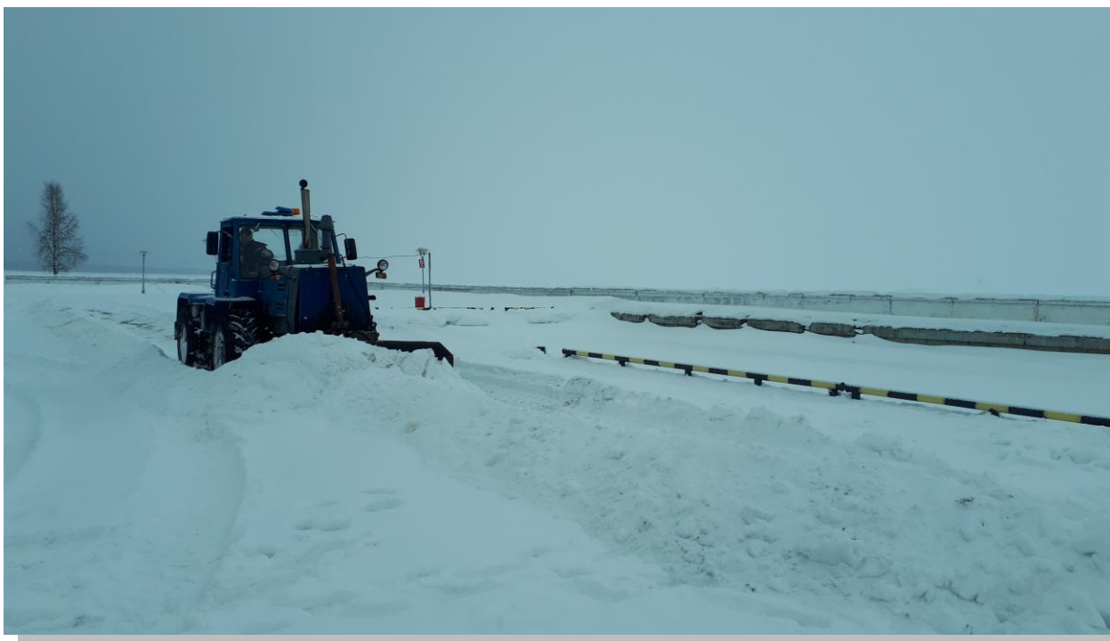
Уборка снега на прилегающей к ГТС территории.
