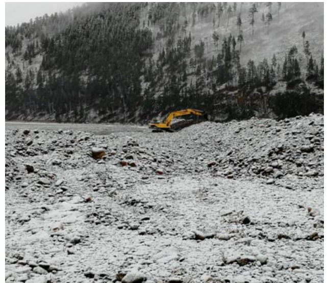
Фото. 5.10. Расчистка русла р. Бирюса в п. Соляная Тайшетского района Иркутской области. . Выполнение работ в 2020 г.
