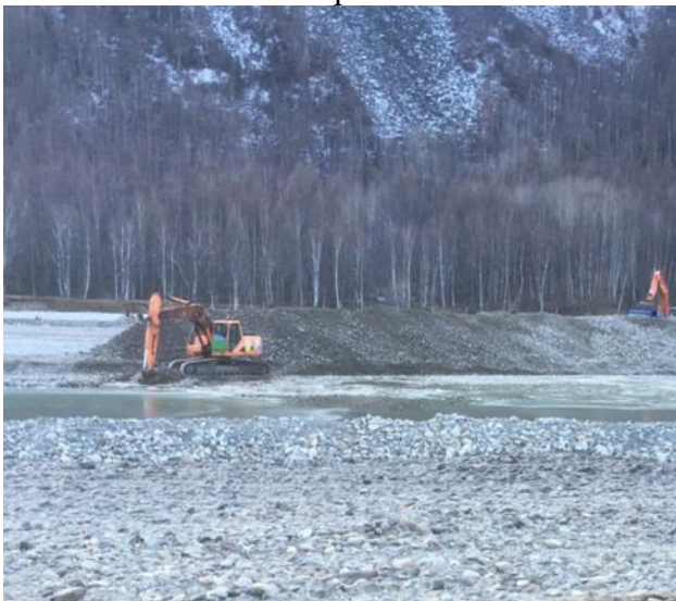
Фото. 5.11. Расчистка и дноуглубление русла р. Уда в с. Алыгджер Нижнеудинского района Иркутской области. Выполнение работ в 2020 г.
