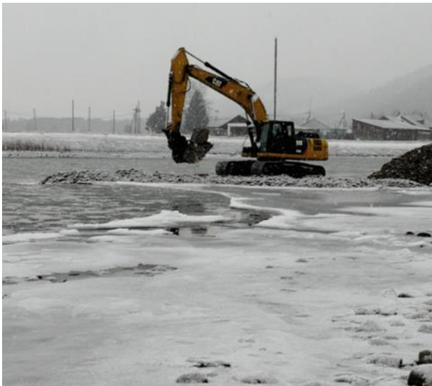
Фото. 5.9. Расчистка русла р. Бирюса в п. Соляная Тайшетского района Иркутской области. Выполнение работ в 2020 г.
