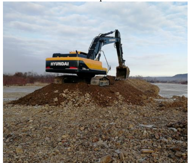
Фото. 5.12. Расчистка и дноуглубление русла р. Уда в г. Нижнеудинск, Нижнеудинского района Иркутской области. Выполнение работ в 2020 г.
