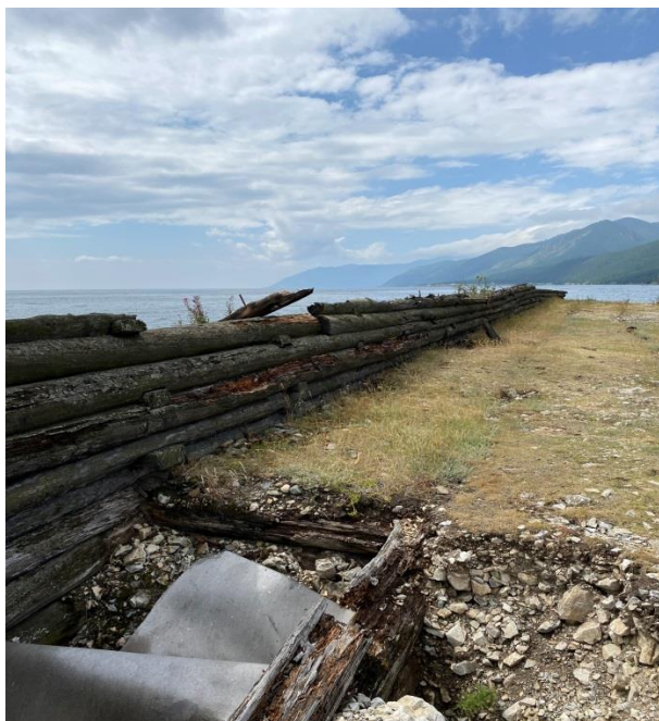
Фото 1,2 Озеро Байкал . Мониторинговая площадка в районе п. Блольшее Голоустрое. разрушенное берегоукрепление
