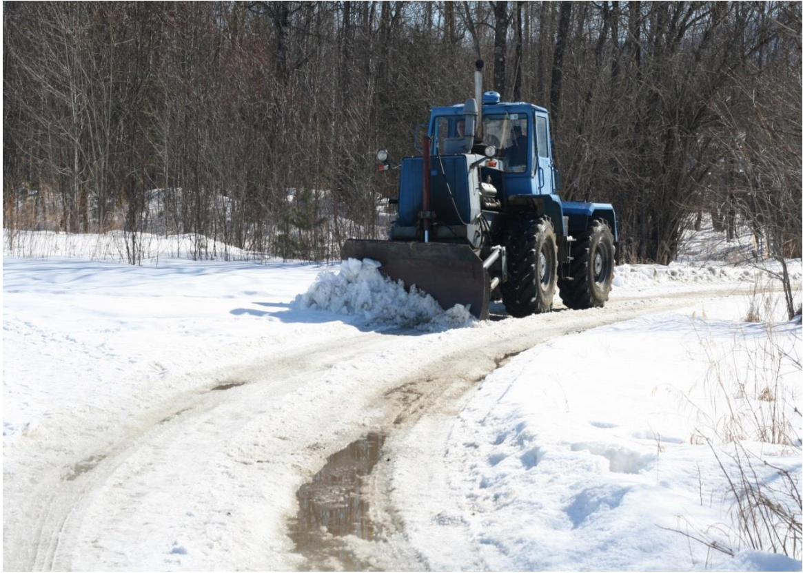
Фото №5.Выполнение работ по уборке снега дороги на ГТС «Берегоукрепительное сооружение в г. Байкальске на озере Байкал, Иркутской области» в марте 2020 год.
