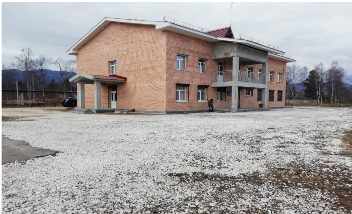
Фото № 3. Уборка у центрального крыльца здания ПЛК Байкальского территориального отдела в апреле 2020 года.
