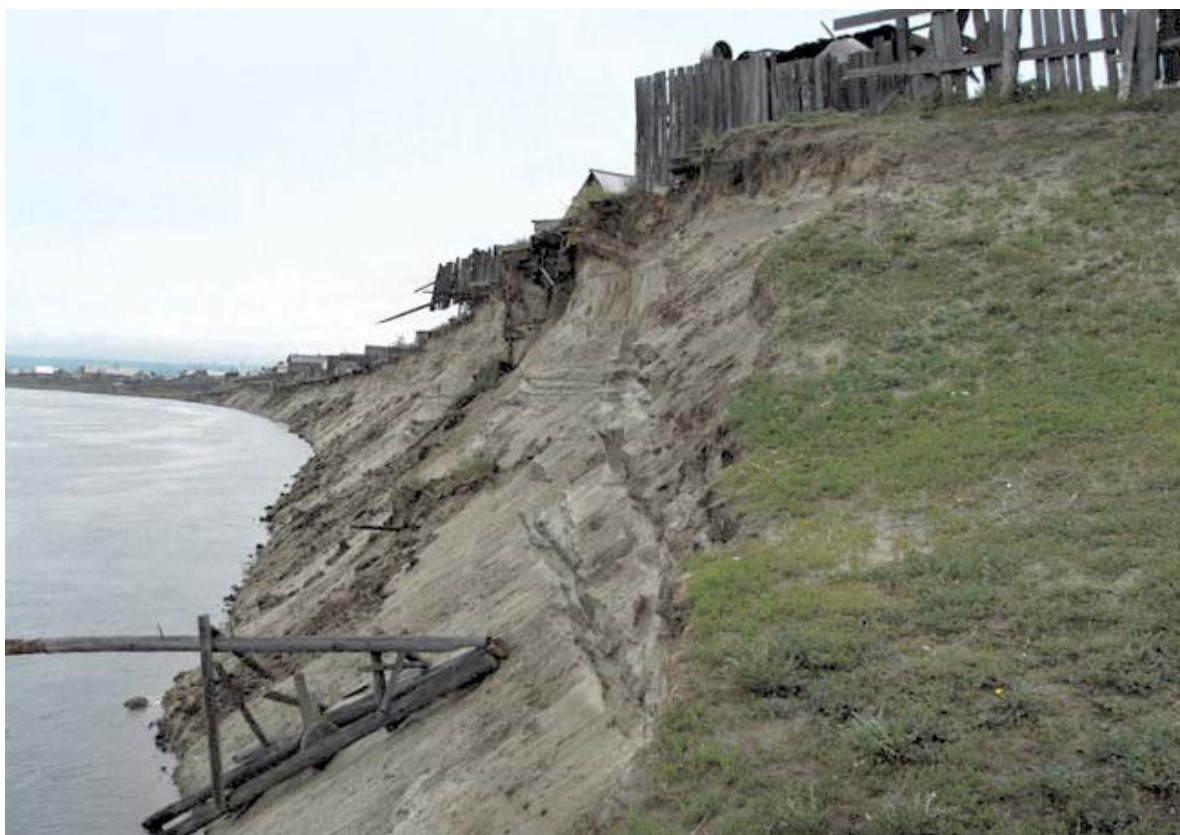
Фото 8.2.1. Разрушение берегов у с. Хатассы
